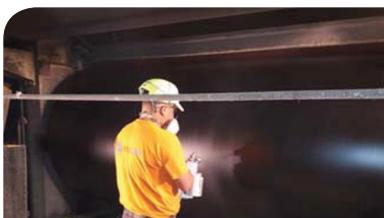
Обработка поверхности на базе Teflon для наилучших антиадгезивных свойств у сушильных цилиндров
